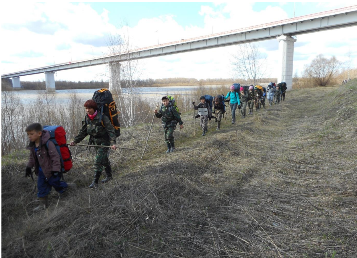
Фото 12. Под пролетом автодорожного моста
